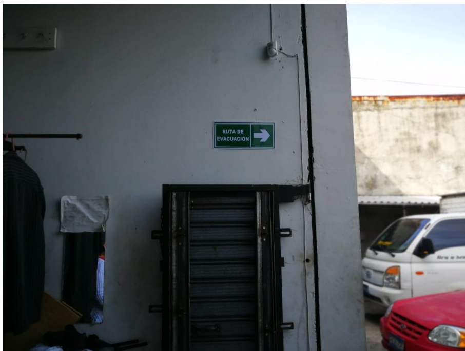
Ilustración 64 Señalización rutas de evacuación
