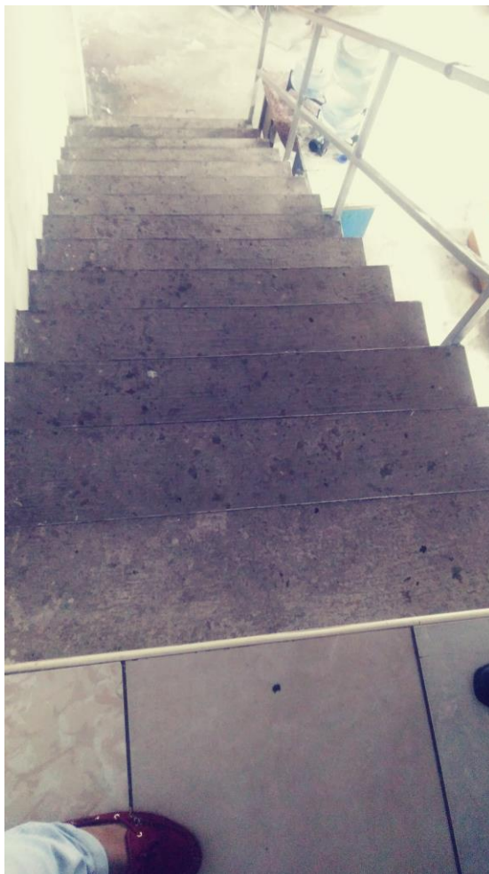
Ilustración 6 Inspección gradas de oficina administrativa
