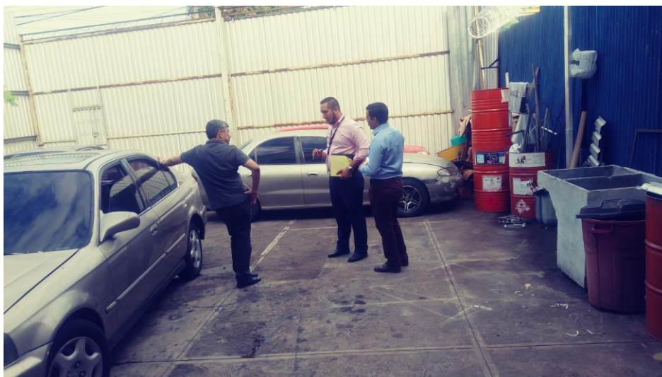
Ilustración 48 Diagnóstico inicial parqueo (ausencia de señalización)
