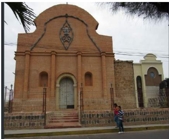
Figura 4. Iglesia parroquial Santiago Apóstol de Apastepeque en proceso de reconstrucción. Imagen tomada de Registro fotográfico propio, durante el trabajo de campo, día 10 de octubre de 2019. Fotografía tomada por: Marlon Sosa.
