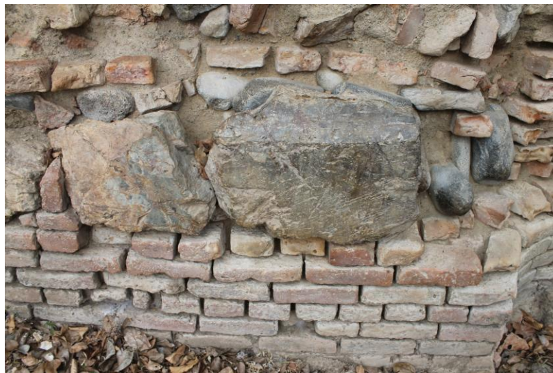
Figura 48. Reparación de la estructura de ladrillos del horno de reverbero, se logra apreciar reutilización de los restos de voladoras ya desgastadas por el uso, así como otras rocas y mortero a base de cal como material de construcción.
