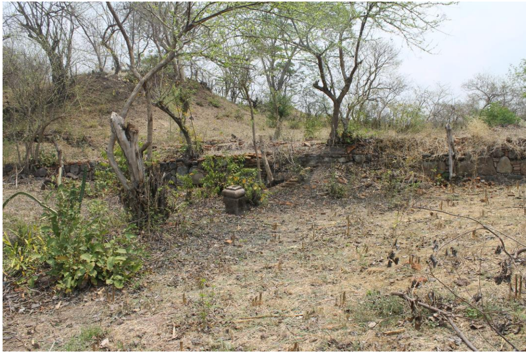
Figura 36. Cimientos y una base de pilar de la Estructura 2, Sector B.
