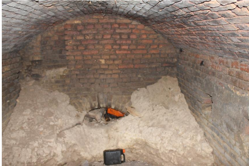
Figura 47. Interior del horno de reverbero, construido a base de ladrillos, se aprecian algunos respiraderos en los costados, así como restos de maquinaria de metal y rastros de hollín en la parte superior de la estructura.
