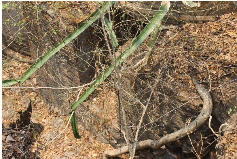
Figura 54. Estructura rectangular que sirve de soporte a los 2 tanques pequeños y que presenta una especie de cuneta bajo los tanques.
