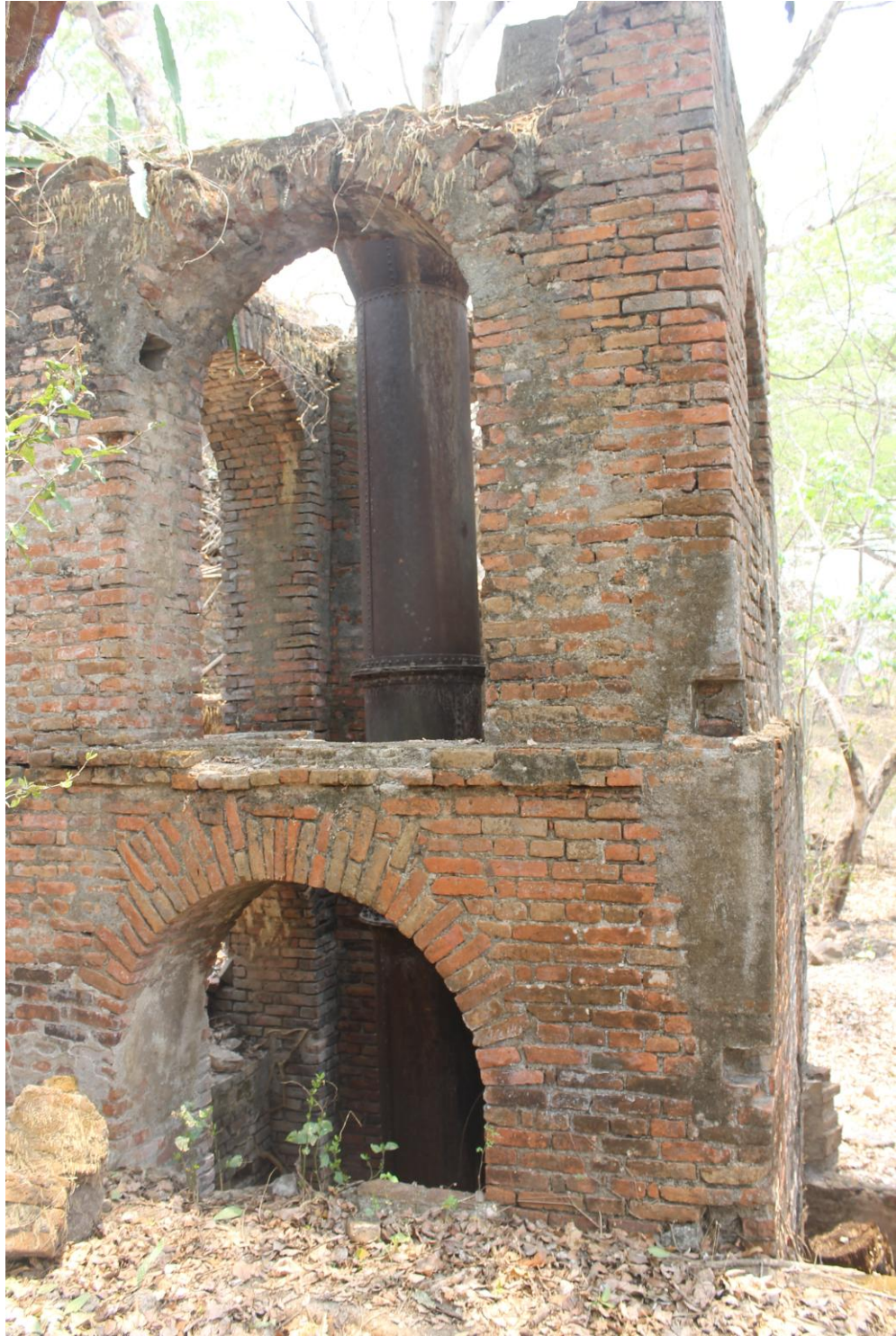
Figura 46. Chimenea de hierro del horno de reverbero y muros de ladrillos.
