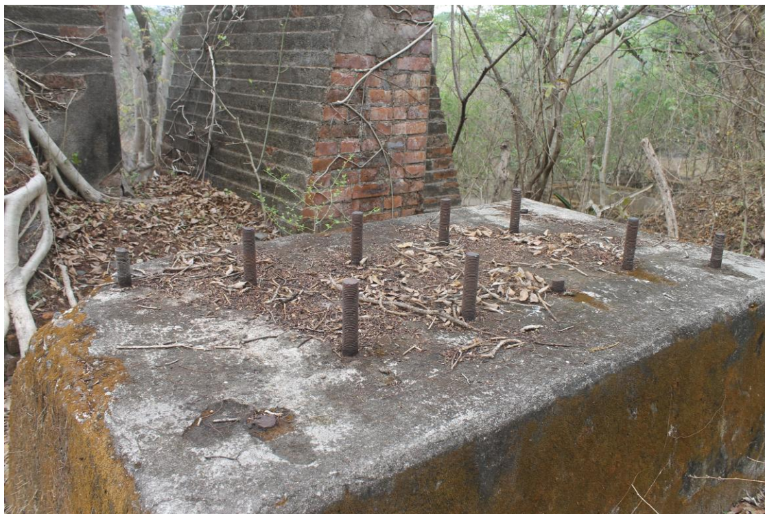
Figura 59. Posible base de motor, con presencia de 10 pernos de gran grosor, los cuales probablemente se adaptaban al motor en su base para brindarle fijación.
