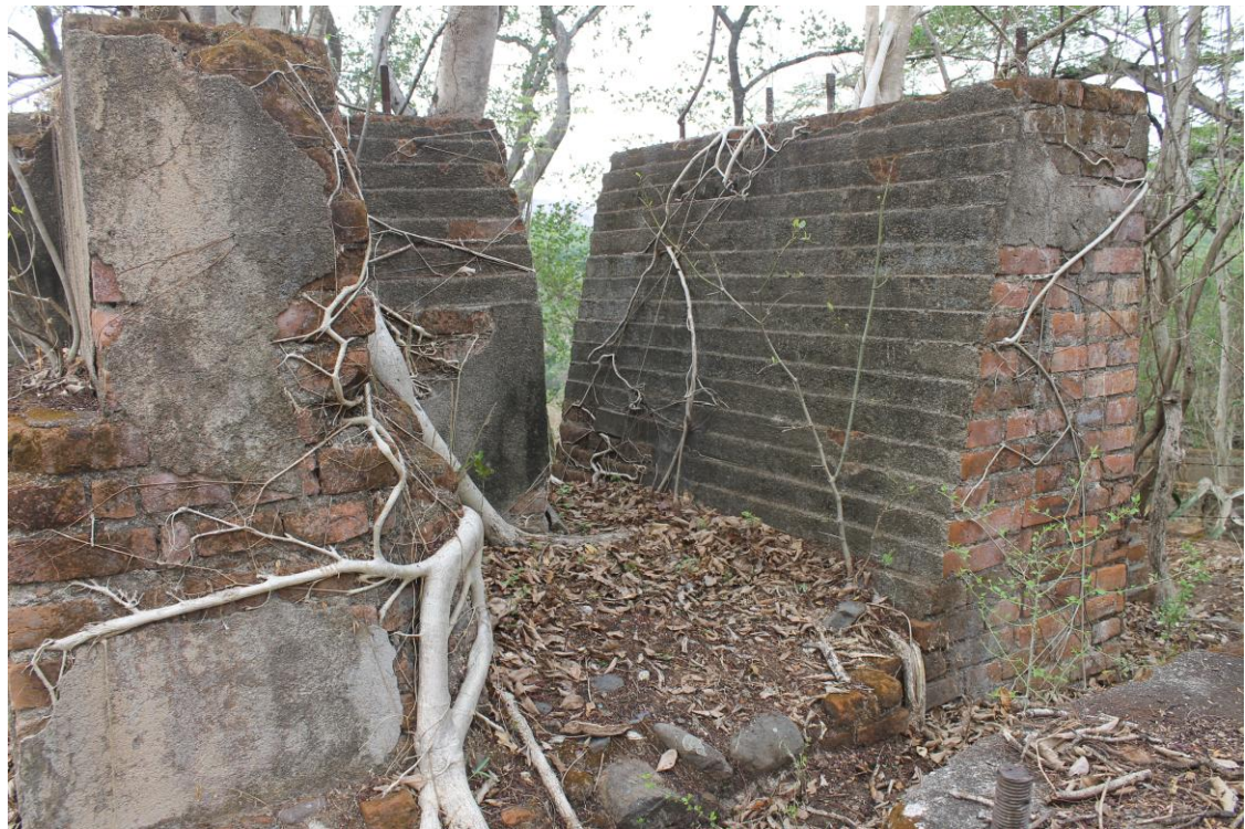
Figura 58. Muros con detalles escalonados y repello de cal. Sobre los muros se logran apreciar pernos de gran grosor, lo que sugiere una forma de fijar la maquinaria pesada en la zona.
