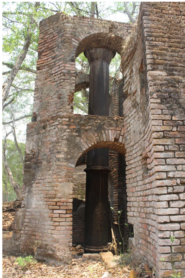
Figura 44. Muros de ladrillos de estructuras adyacentes al molino que poseen curvatura en sus muros externos para permitir el funcionamiento del molino.
