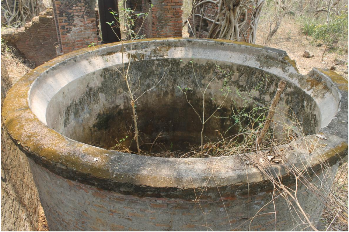
Figura 52. Borde superior de los tanques, con posibles adaptaciones para sistema de agitado.
