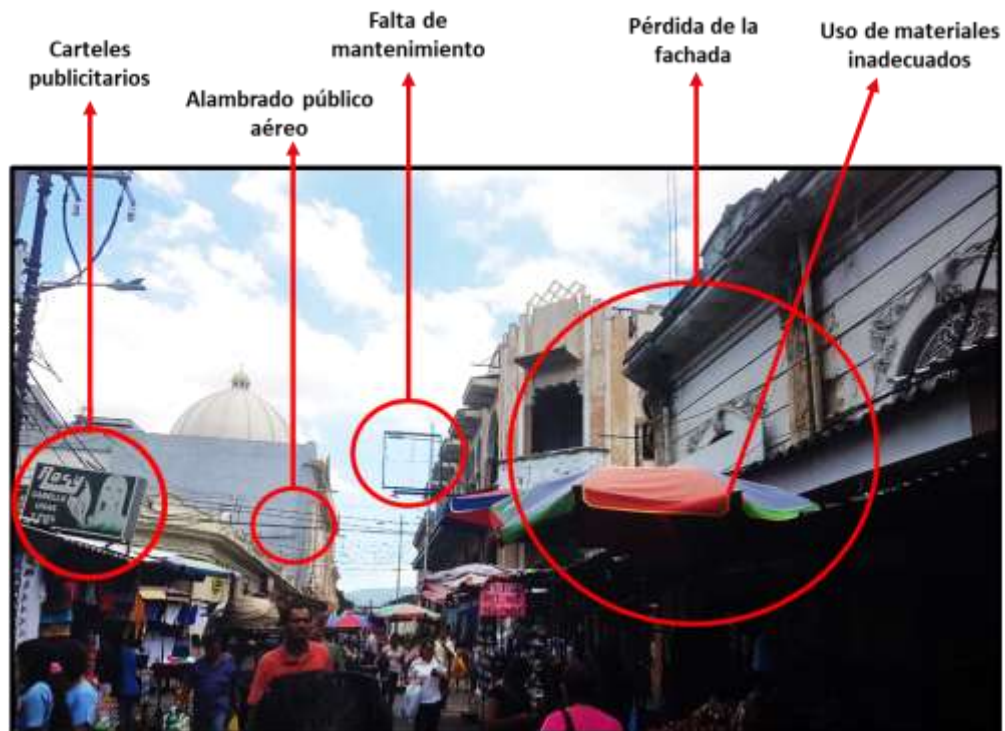
Ilustración 12 - Calle Delgado Fotografía tomada en visita de campo 2018
