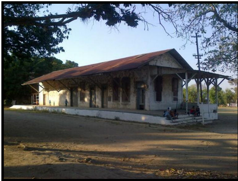
Estación de Tren
