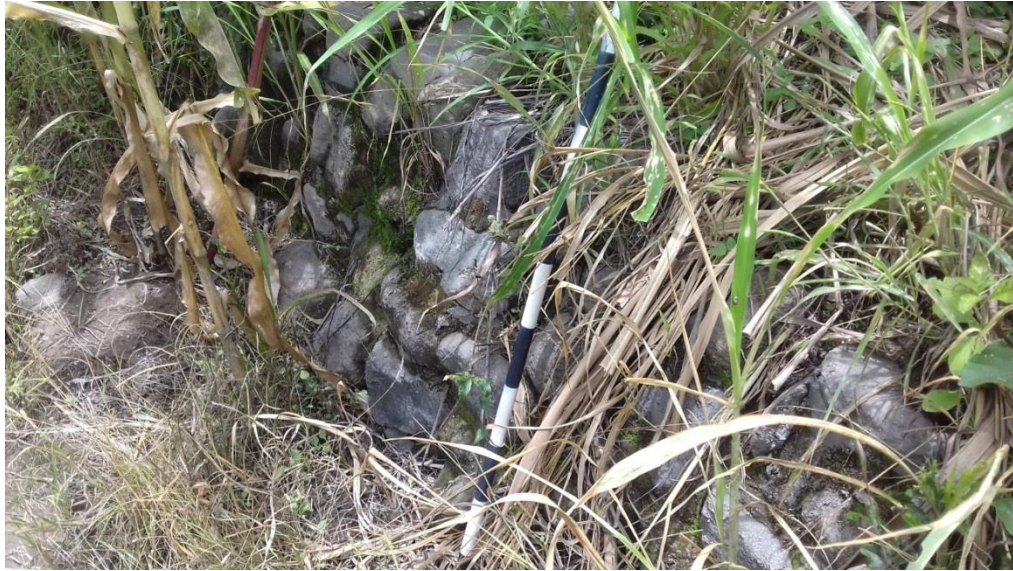
Figura 37: Muro construido recientemente en el sitio. Tomada por Katherine García, 2017.
