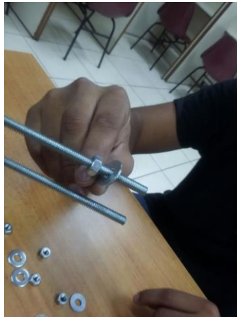
Figura 21, colocación de la tuerca y la arandela.
