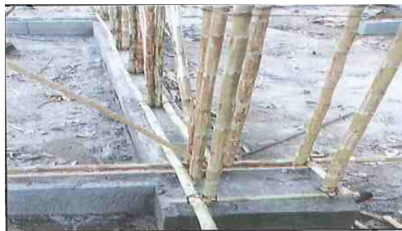
Ejemplo de colocación de sobre-cimiento.
