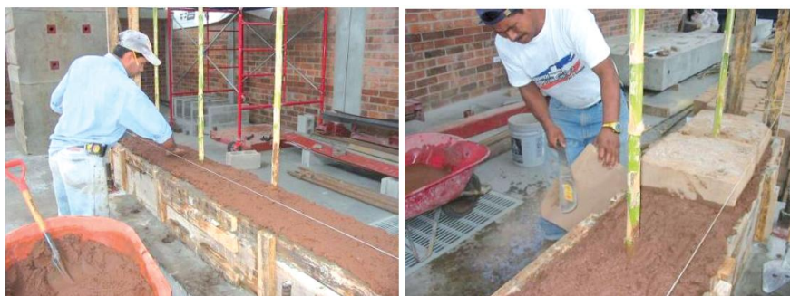
Colocación de adobes, colocación del mortero sobre el cimiento y puesta de la primera hilada de adobes.
