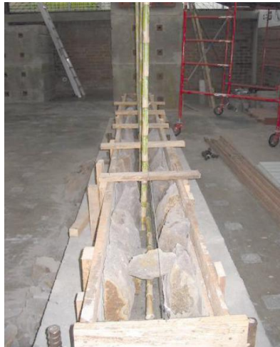
Colocación de varas de castilla en pared reforzada
