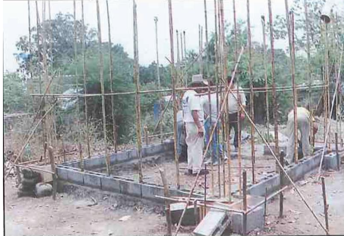
Colocación de contrafuertes y entramado horizontal y vertical
