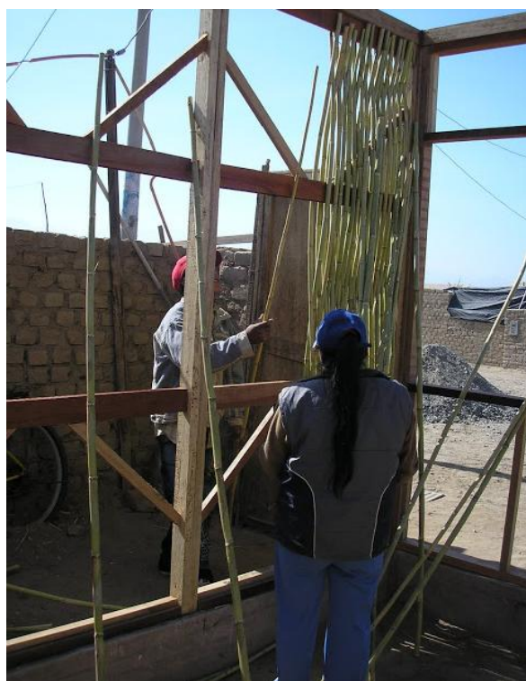
Ejemplo de sobre-cimiento y colocación de paredes de quincha
