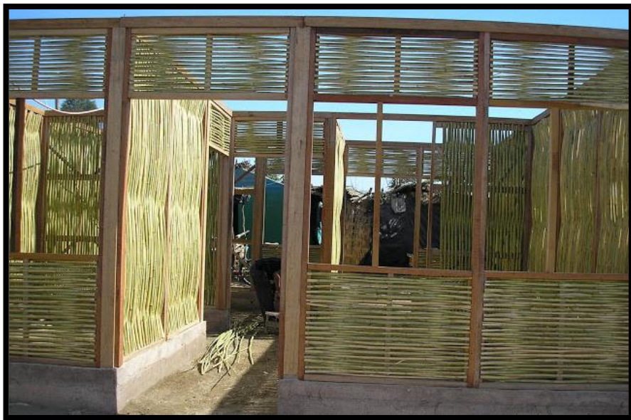
Forma de la trama en que se ponen los paneles de quincha.
