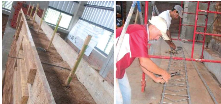
Armado y encofrado de solera de coronamiento.
