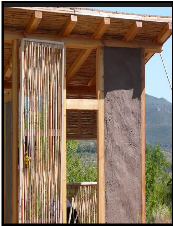
Forma de la trama en que se ponen los paneles de quincha.
