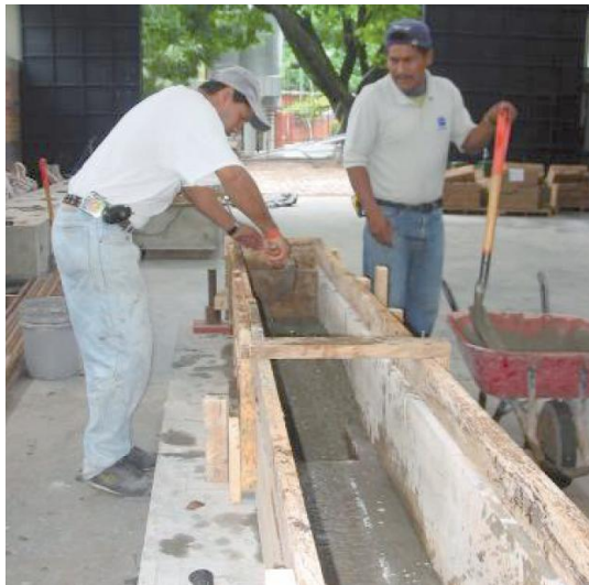
Moldeado de la fundación de las paredes de adobe
