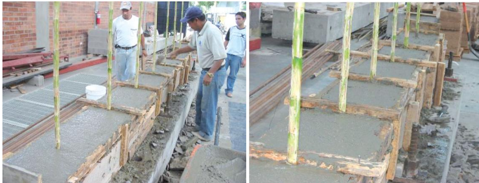
Muestra del acabado final de la superficie de la cimentación
