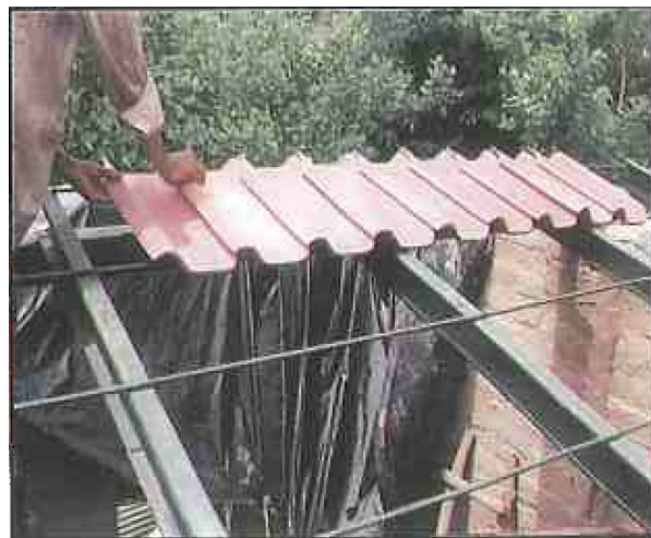
Colocación de las vigas y largueros para la colocación del techo
