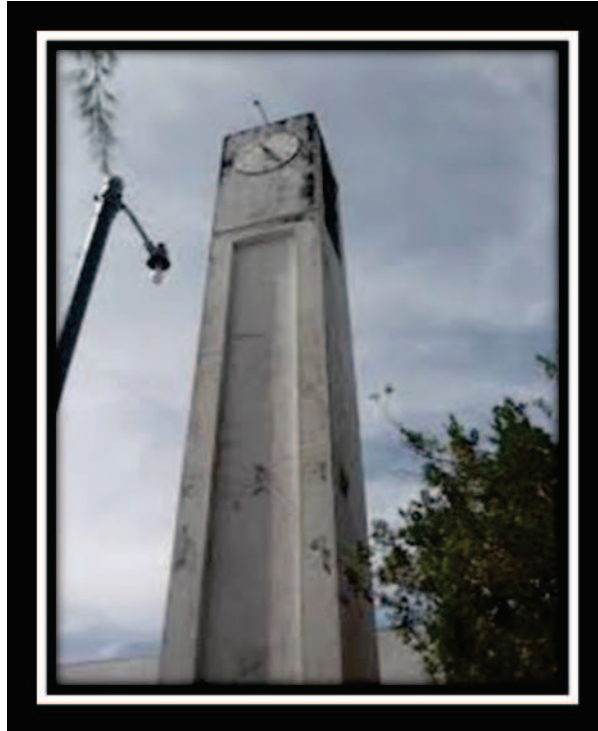
Anexo 6. Torre del Antiguo Reloj.
