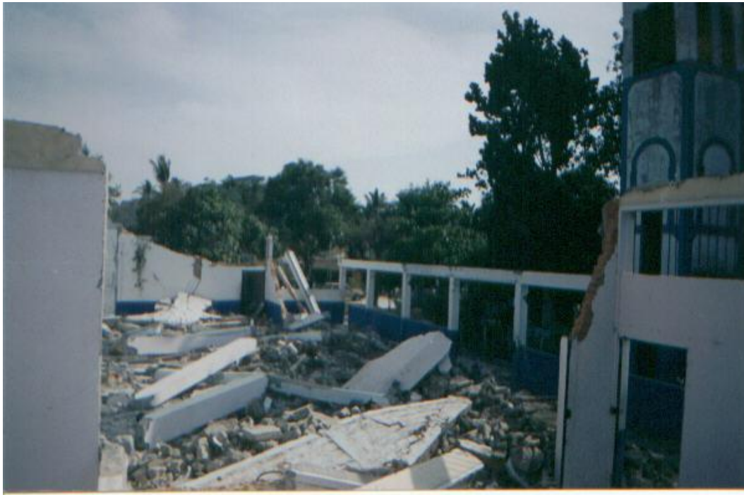
RUINAS INTERIORES ALCALDIA MUNICIPAL
