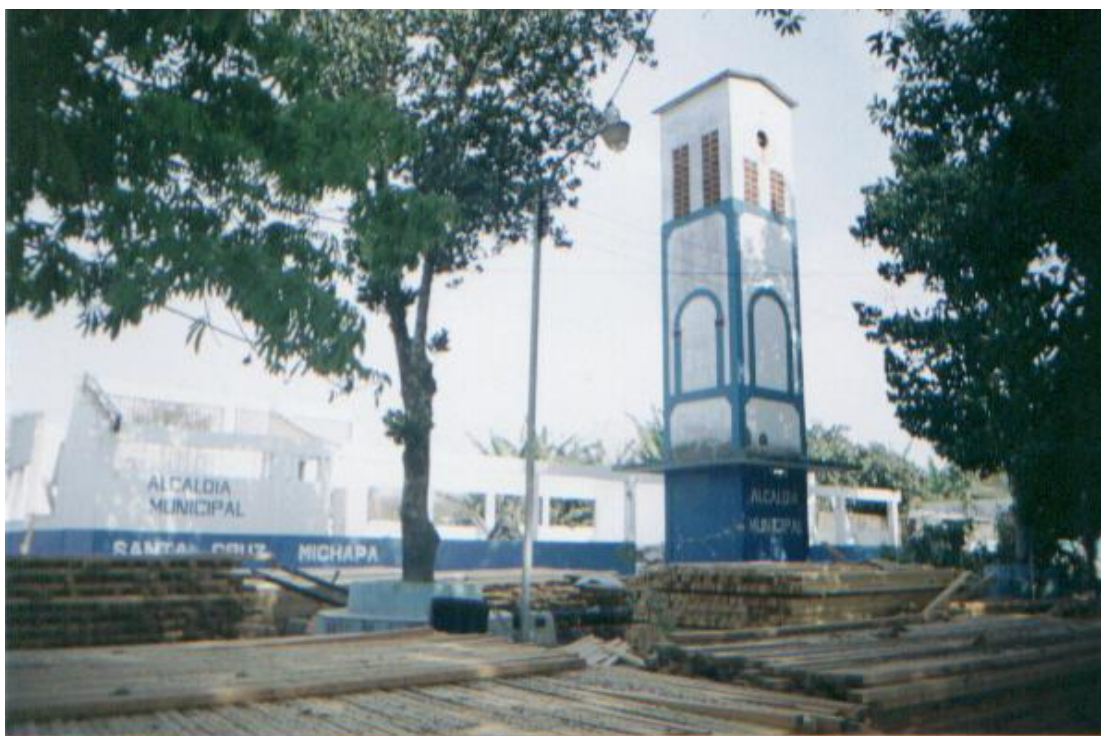
FACHADA PRINCIPAL COLAPSADA ALCALDIA MUNICIPAL
