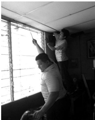
Fotografía # 5: Instalación de cable UTP
