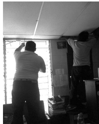
Fotografía # 6: instalación cable eléctrico
