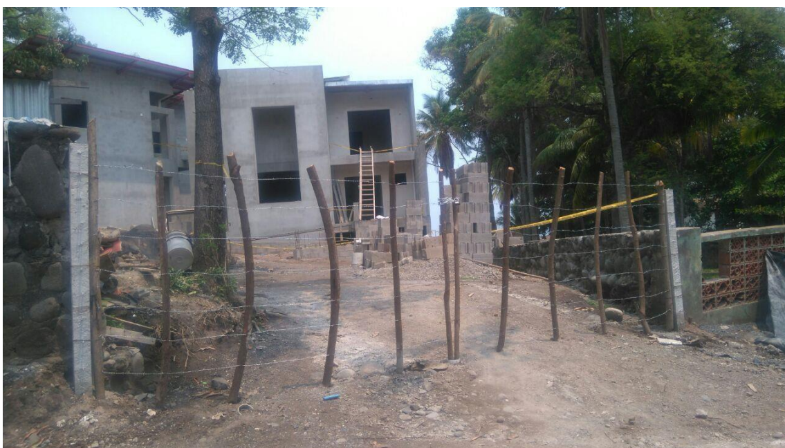
Foto #1 construcción de Hotel Palo Verde
