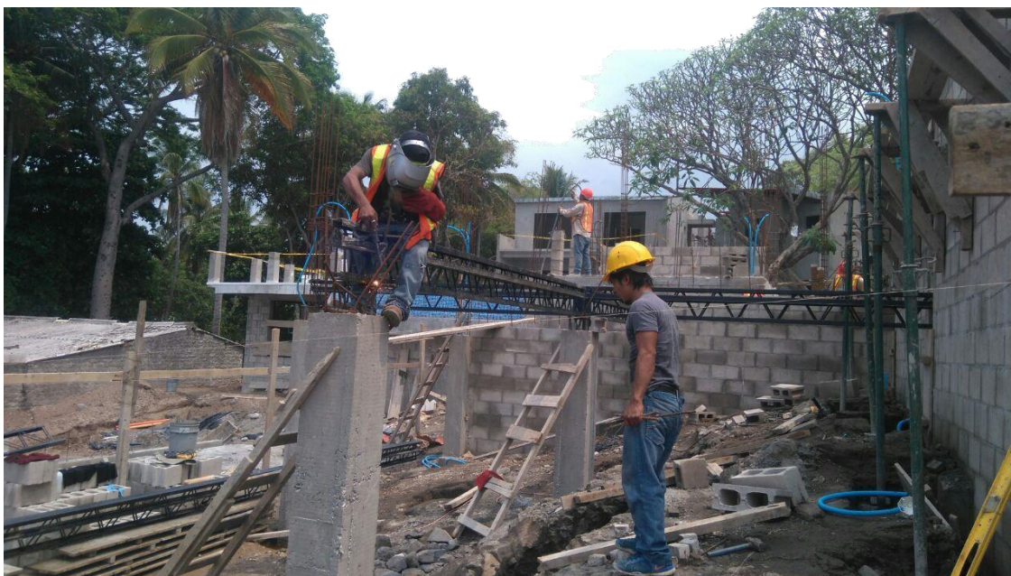
Foto #6 construcción de Hotel Palo Verde
