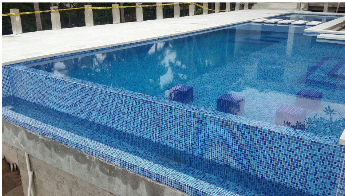
Foto #5 construcción de Hotel Palo Verde
