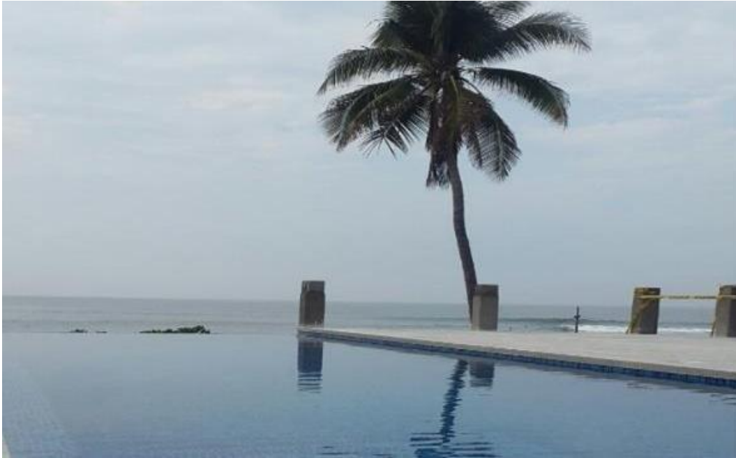
Foto #8 construcción de Hotel Palo Verde
