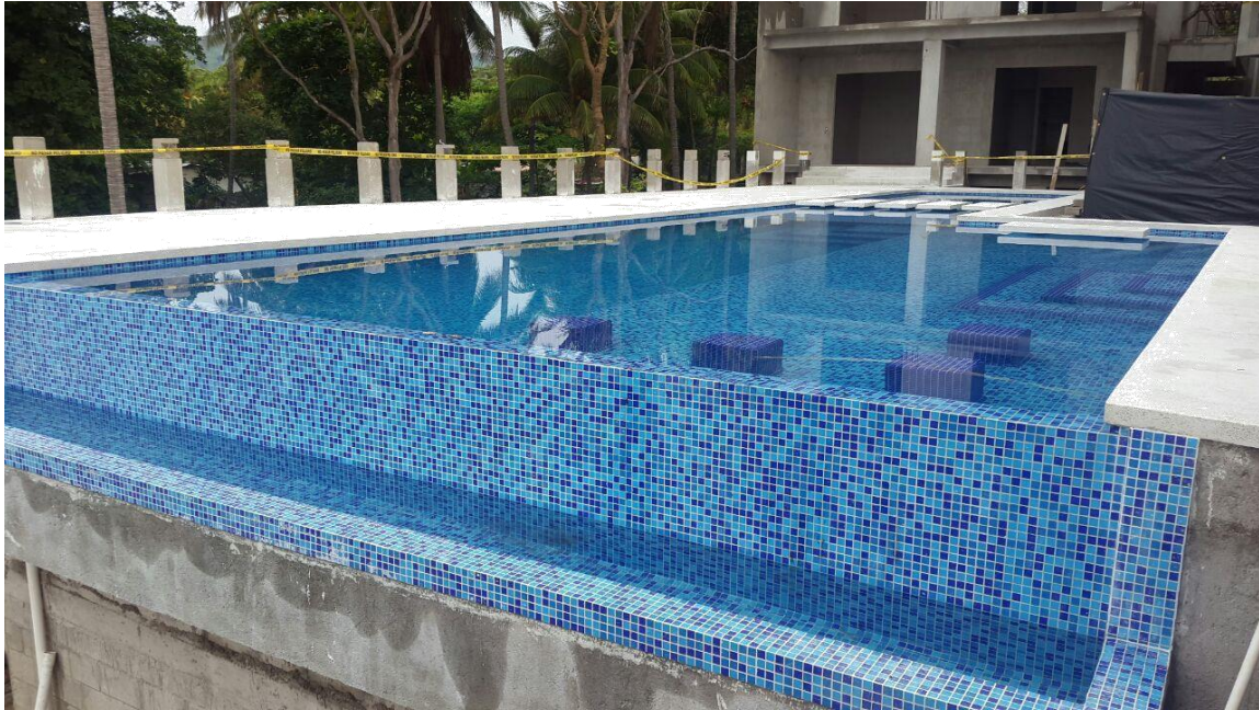
Foto #2 construcción de Hotel Palo Verde
