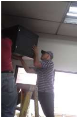
Figura 1 Verificación del Rack y patch panel, cambio de cableado e instalación de ordenador.
