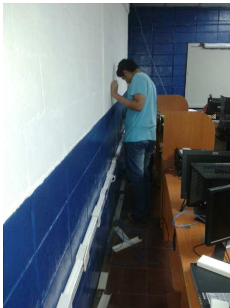
Figura 3.13: Instalación de canaleta horizontal y puntos de red en pared lateral.
