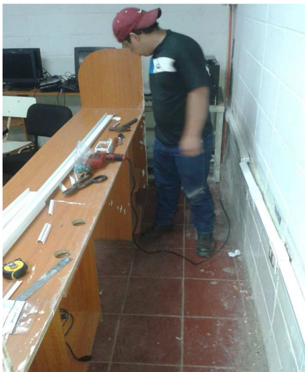
Figura 3.14: Instalación de canaleta y puntos de red.
