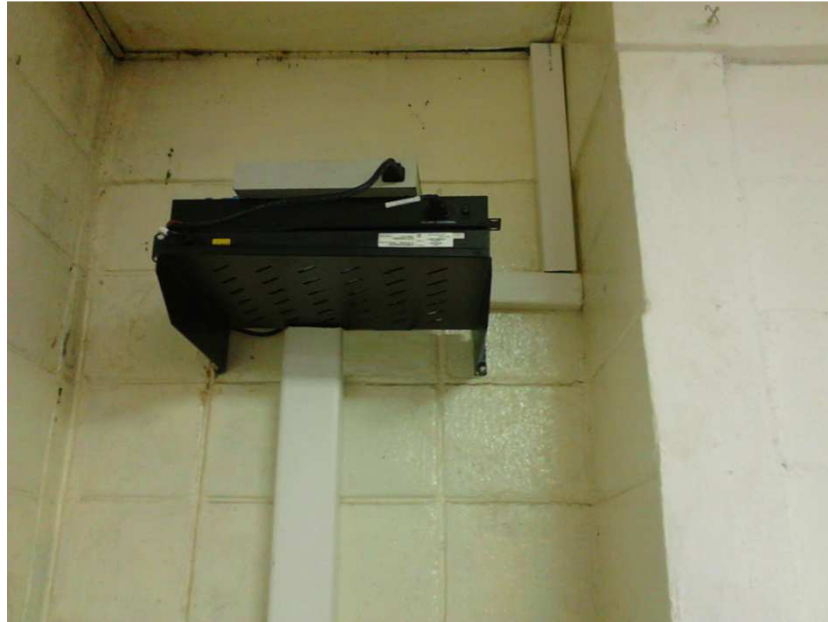
Figura 3.16: Instalación de equipos en bandeja ventilada.
