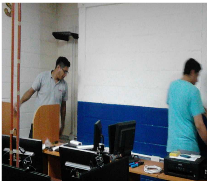
Figura 3.15: Instalación de bandeja, canaleta vertical, horizontal y puntos de red.
