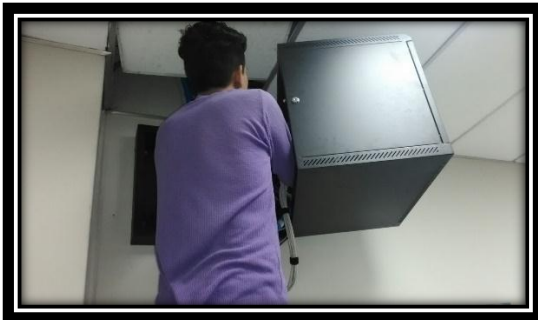
Ponchado de cables en path panel.
