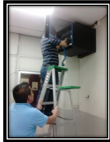
Conexión de los cables path cord con el path panel y switch
