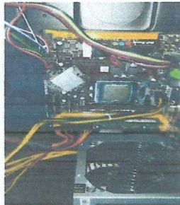
Fig. 12: Conexión de cables.
