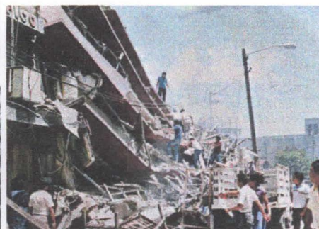
Edificio Rubén Darío Colapsado.
