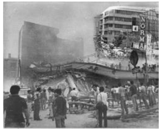
Destruído en el terremoto de 1986
