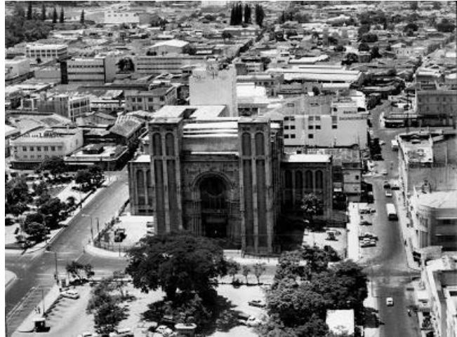
Vista panorámica de la Catedral Metropolitana en construcción, en los años 60s.
