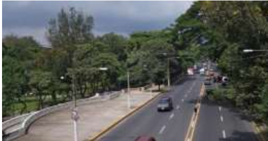
Calle Avenida Roosevelt.
