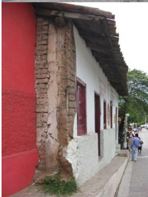
Caracterización de edificaciones en el centro de Panchimalco
