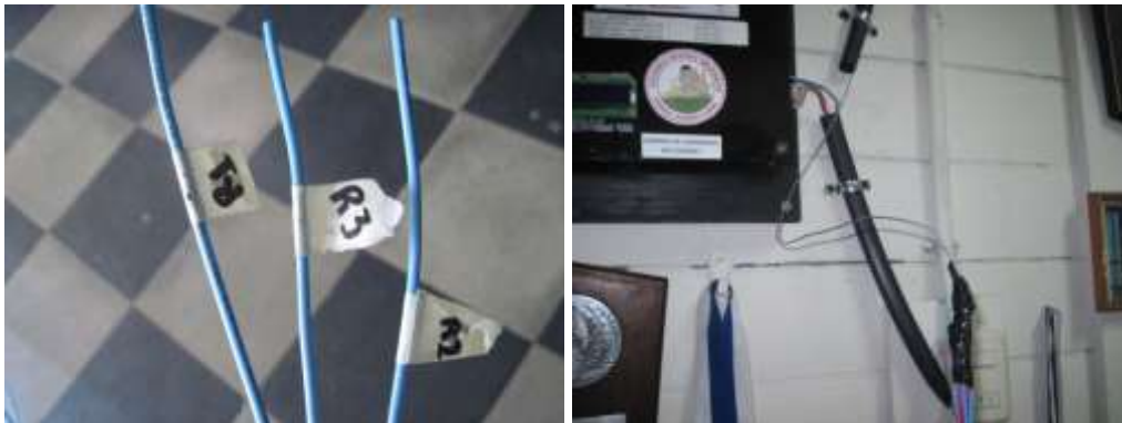
Figura 3.11 Se le colocaron nombre a cada alambre para poder identificarlos a la hora de empalmar, luego se pasaron los alambres a través del poliducto mediante un alambre galvanizado.
