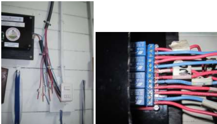
Figura 3.15 Se colocaron los alambres provenientes de cada aula a su respectivo relé del equipo electrónico.
