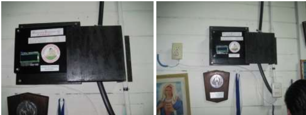
Figura 3.16 Se colocó una tapadera de madera la cual servirá para proteger los alambres del exterior.
