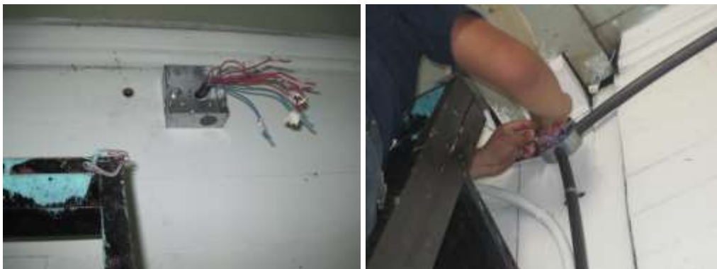
Figura 3.12 Se colocaron cajas de registro en cada aula/salón donde se realizaron los empalmes correspondientes de cada luminaria al módulo de relés.
