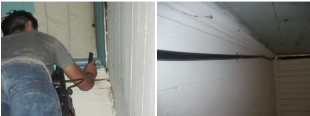
Figura 3.10 Se taladro la pared del área principal donde se desplazó el poliducto el cual se aseguró a la pared de madera, por medio de grapas galvanizadas y tornillos golosos.
