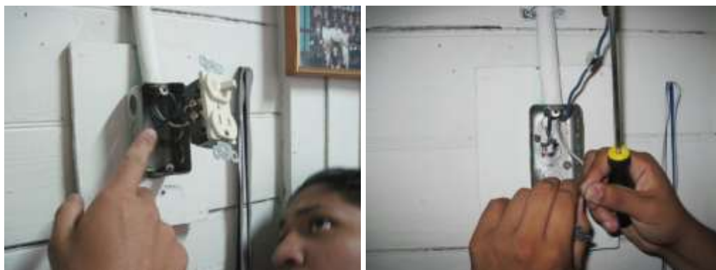
Figura 3.13 Se cambiaron los switch monofásicos de cada aula/salón.
