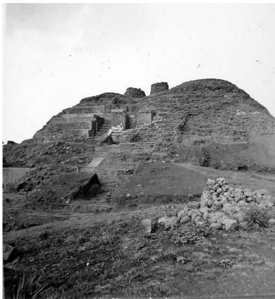
Figura 10. Estructura 1. Finales de la temporada 1948
