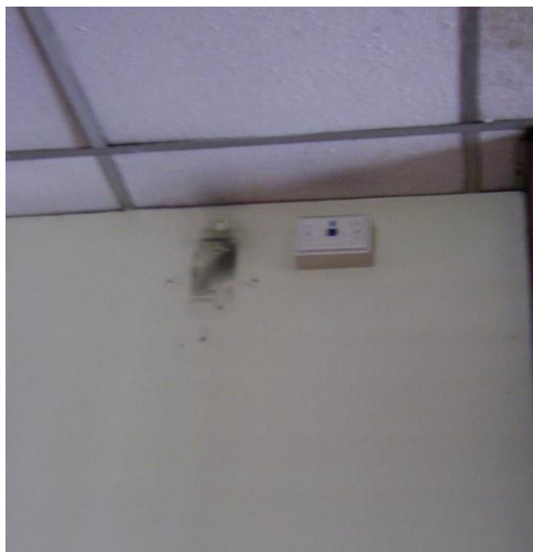
Figura 3.8 ausencia de puntos de acceso.
