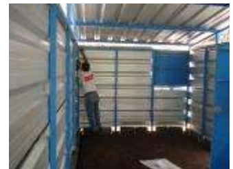
Construcción de "Un techo para mi país"
