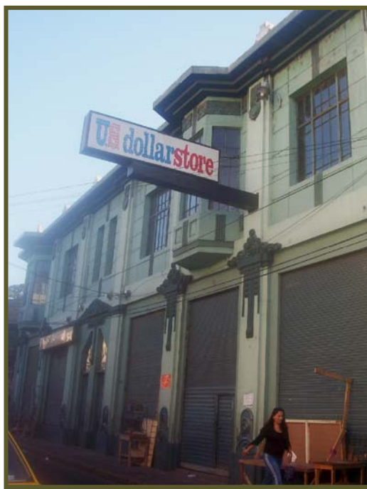
Edificio San José Manzana G - 4; Inmueble 1 Fecha aproximada de construcción 1930 - 1940
