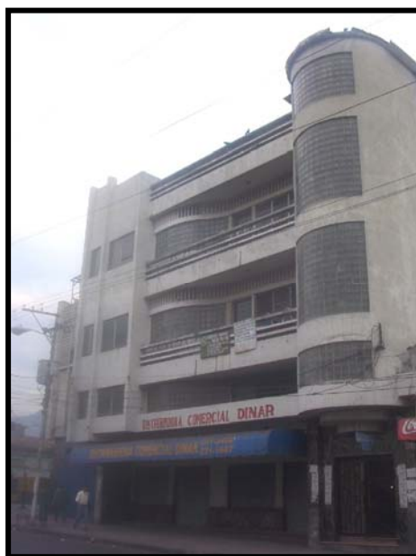
Edificio Rodríguez Porth Manzana A - 7; Inmueble 2 Fecha aproximada de construcción 1960
