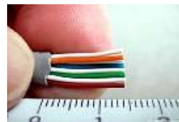
Figura 3.21 Pelar el cable
