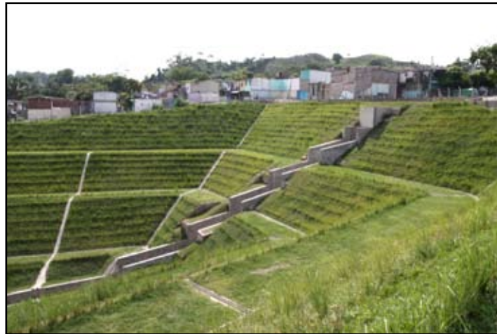
Finaliza las obras de mitigación de riesgos en de residencial Las Cañas.
