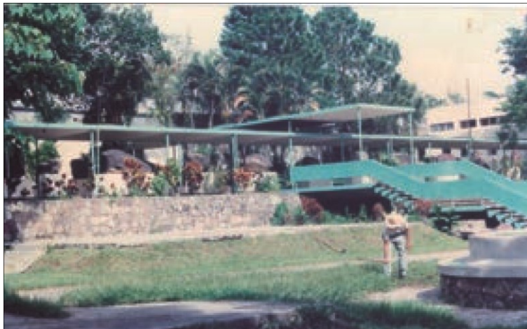
Imagen 3. Fachada principal del antiguo museo nacional ubicado en la avenida La Revolución de la colonia San Benito, en la que se observa el pasillo rupestre. Fotografía cortesía de Sandra Alarcón.
