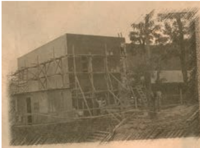
Imagen 8. El actual edificio del Museo Nacional de Antropología en proceso de construcción a finales de los años 90. Fotografía cortesía de Sandra Alarcón.
