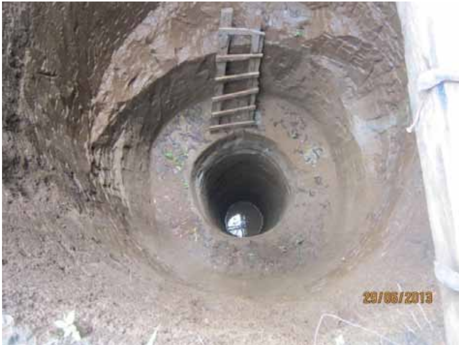
Figura 10. Vista de pozo en Ahuachapán en casa de Mauro Herrera. Modelo de captación de aguas lluvias (sin tapar) labrado en la tierra. Modelo del ingeniero Mauro Herrera, de El Salvador. Foto Carolina Lucero y Sandra Majano.
