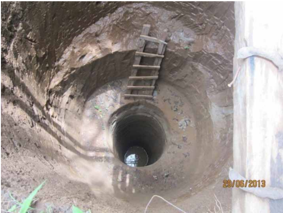
Figura 11. Modelo de captación de aguas lluvias (sin tapar) labrado en la tierra. Modelo del ingeniero Mauro Herrera, de El Salvador. Foto Carolina Lucero y Sandra Majano.
