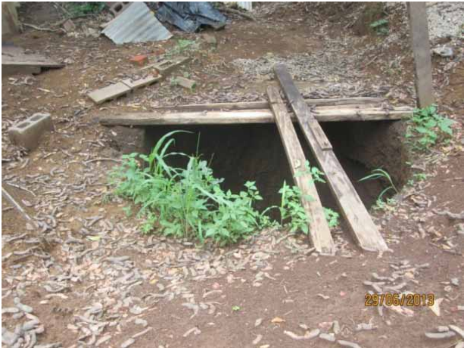
Figura 9. Pozo parcialmente tapado. Modelo de captación de aguas lluvias (sin tapar) labrado en la tierra. Modelo del ingeniero Mauro Herrera, de El Salvador. Foto Carolina Lucero y Sandra Majano.
