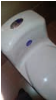
Inodoro de doble descarga
