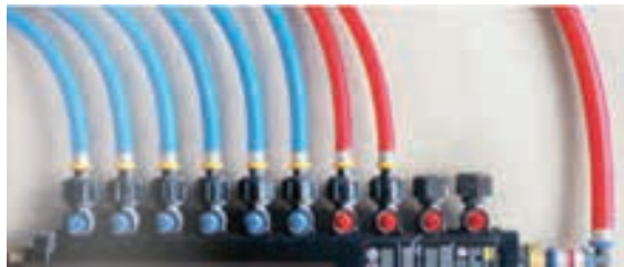
Dispositivo para controlar el agua potable en diferentes lugares de la vivienda
