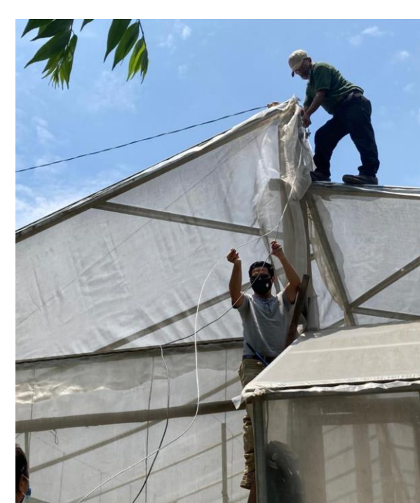
Imagen 2. Instalación de sistema
