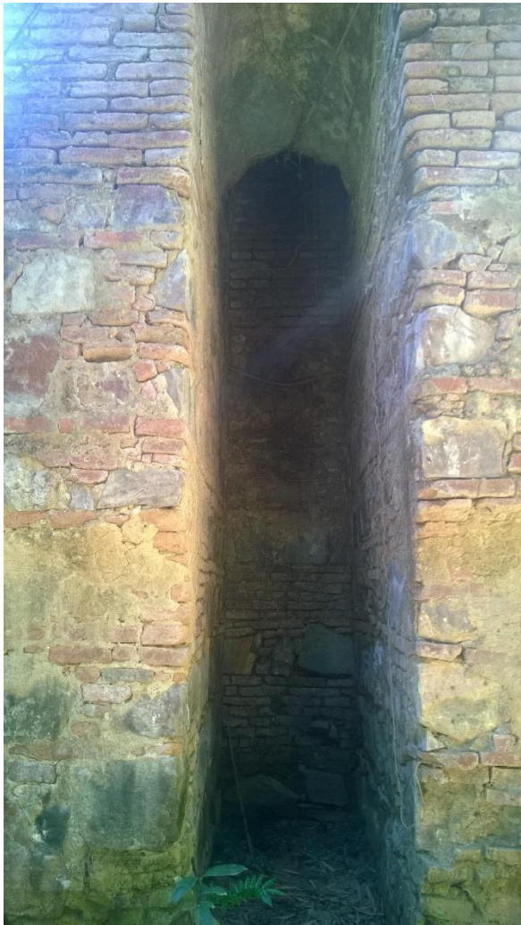
Figura 32. Vista de Pila de caída
