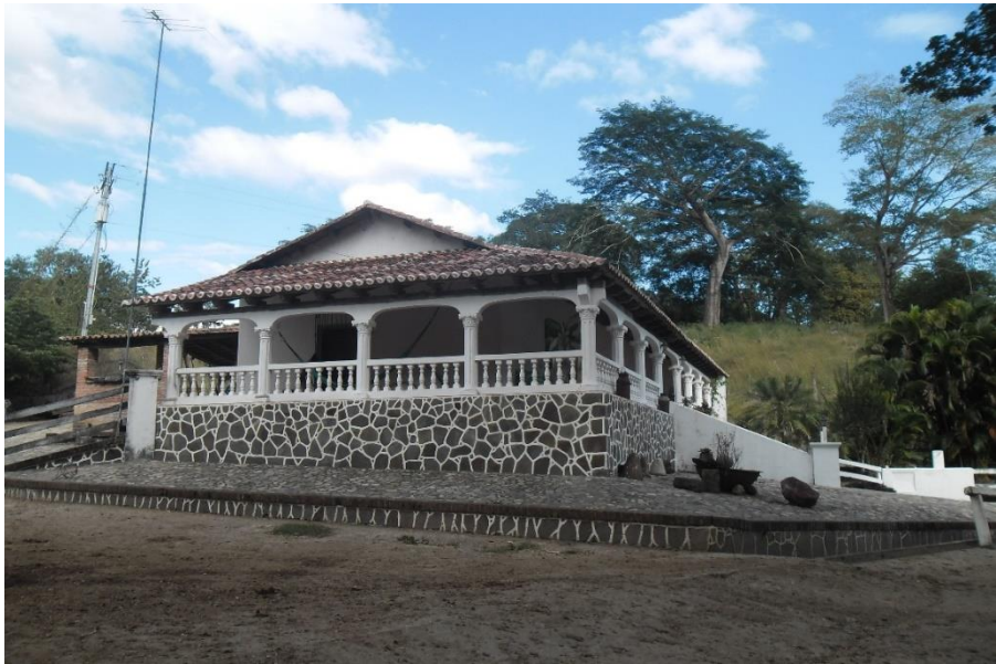
Figura 18. Vista de la casa principal del casco de la hacienda (Figura captada por Isis Pasasin, 2016).
