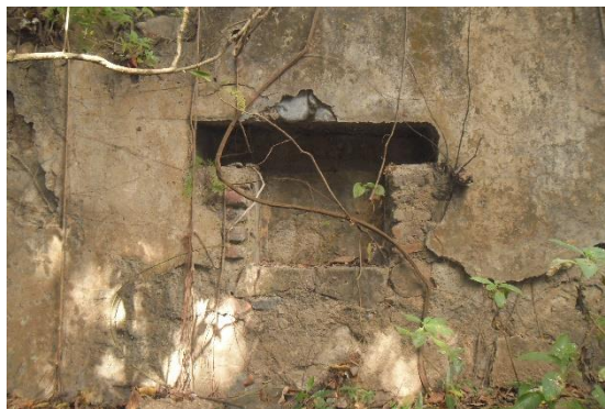
Figura 25. Parte del muro noreste del Ingenio San Miguel.
