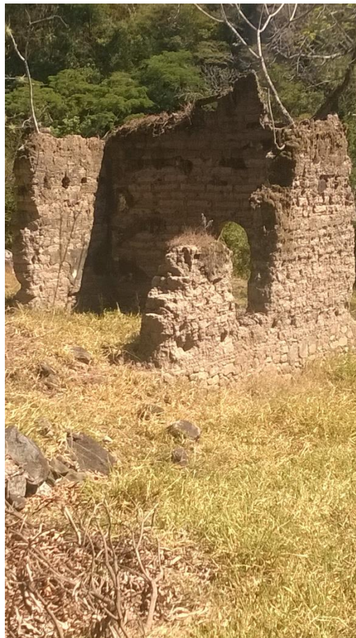
Figura 34. Vista de la estructura del Ingenio San Rafael que se pudo identificar en la visita
