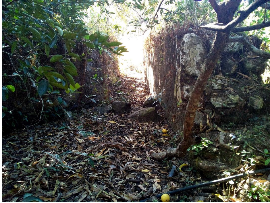
Figura 31. Vista de la canaleta
