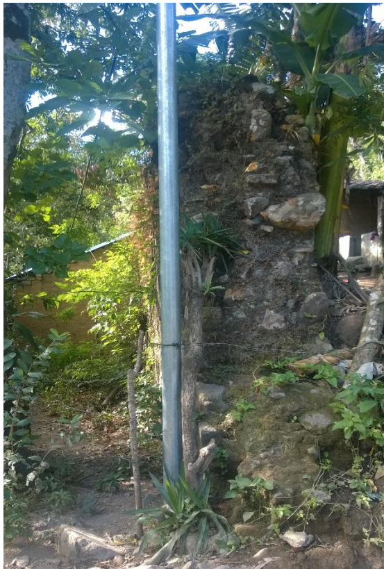
Figura 19. Columna a un lado del camino entre las casas que se han construido en el ingenio.
