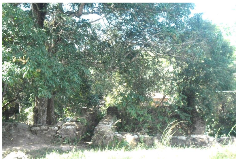
Figura 8. Vista canaleta sur. (Figura captada por Isis Pasasin, 2016).
