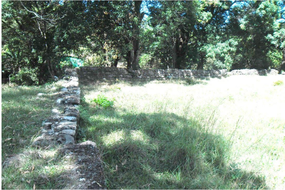
Figura 9. Vista del muro sur que se encuentra en el ingenio. (Figura captada por Isis Pasasin, 2016).
