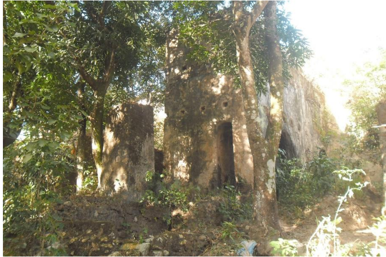
Figura 20. Vista Sur Este de la pila de caída del Ingenio San Miguel
