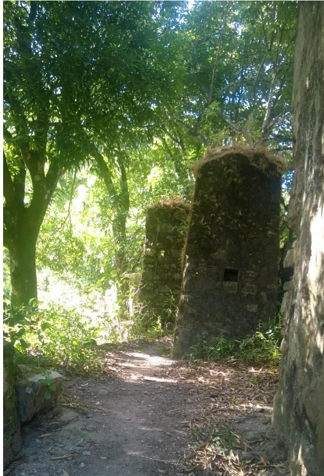
Figura 24. Vista de algunas de las columnas de las instalaciones que aún permanecen.
