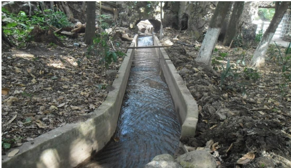
Figura 16. Canaleta moderna (Figura captada por Isis Pasasin, 2016).
