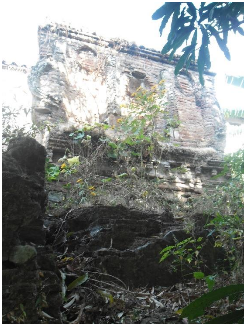
Figura 27. Muro de la estructura sanitaria
