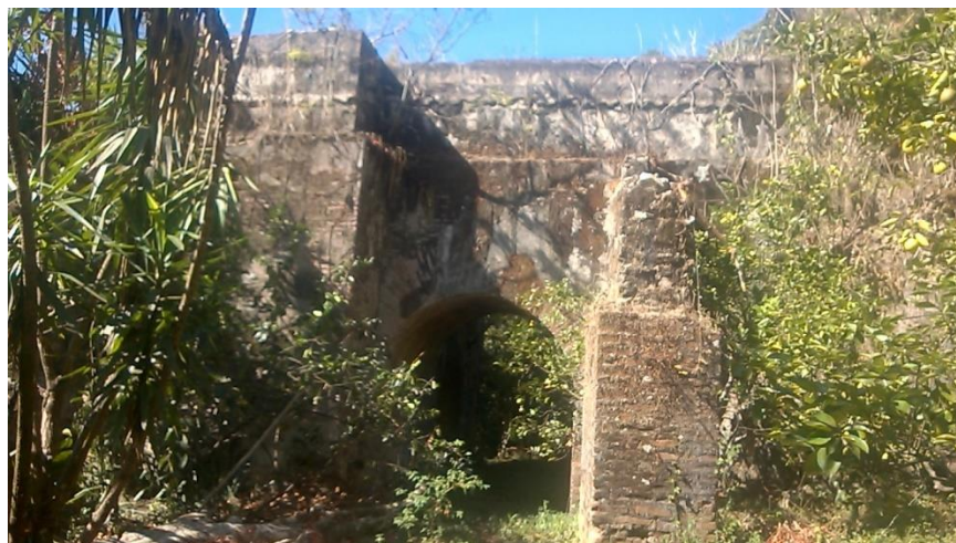
Figura 29. Vista Sur Oeste del Ingenio El Rosario, Metapán.
