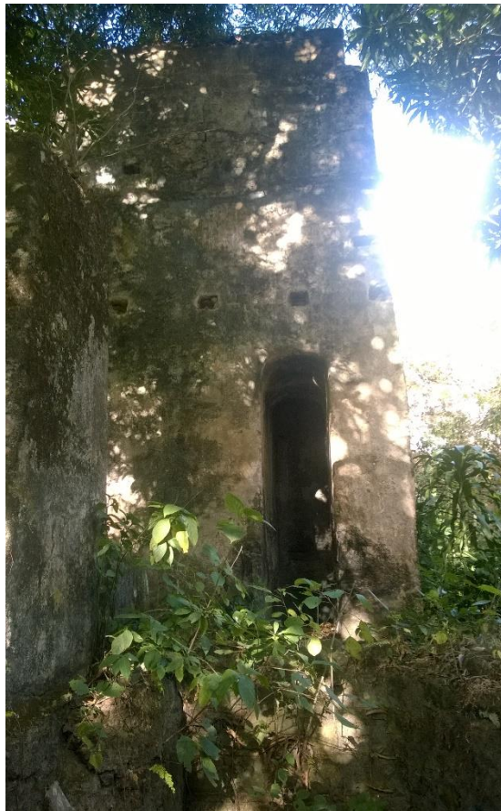
Figura 21. Vista más cercana de la pila de caída del ingenio.
