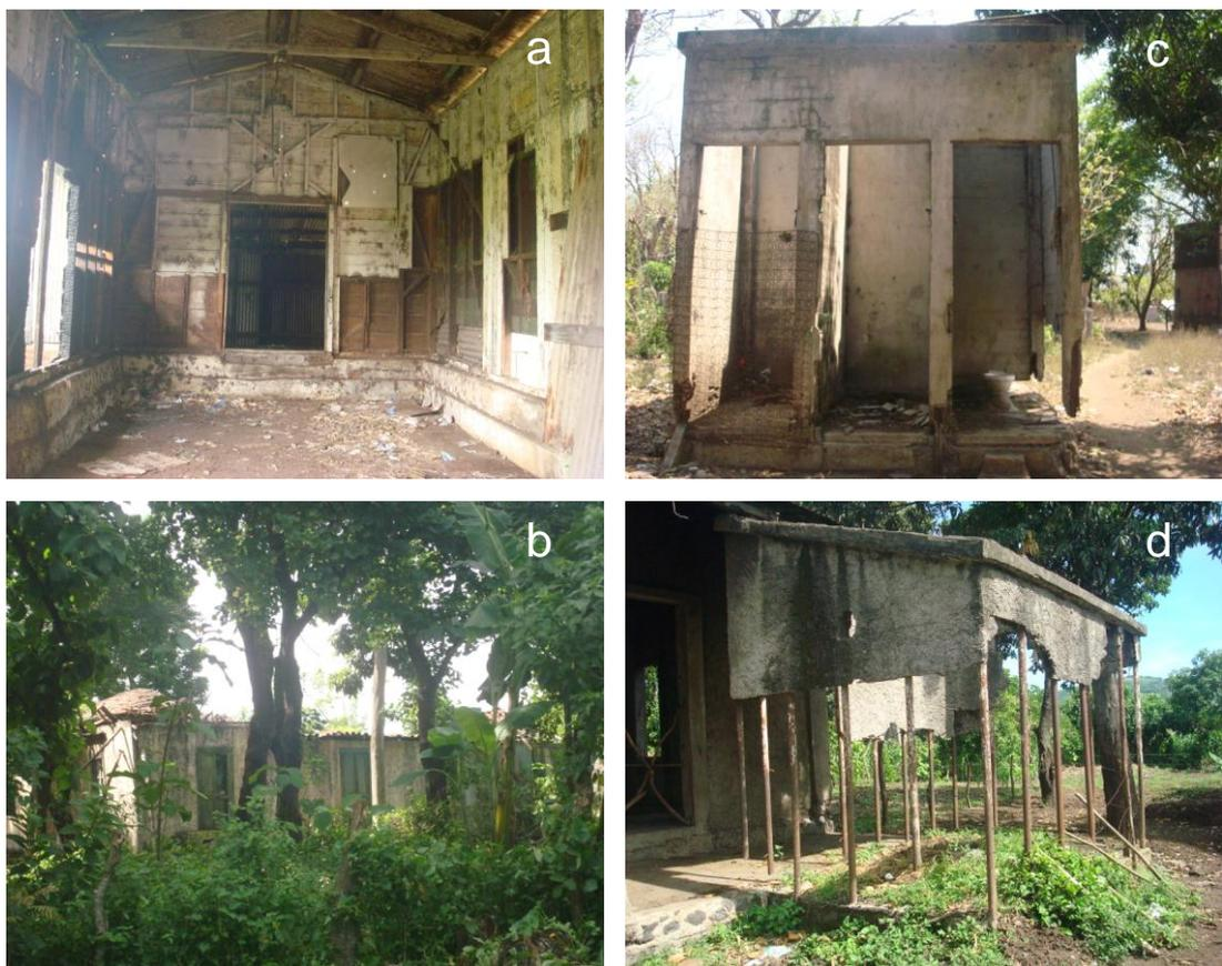
**Figura 41. Estado de conservación de algunos inmuebles en Conjunto ferroviario Sitio del Niño. Sala de espera, estación ferroviaria (a), Casa sección (1), vista desde el Oeste (b), Sanitarios (c) y Casa sección (3), vista desde Este (d)**
