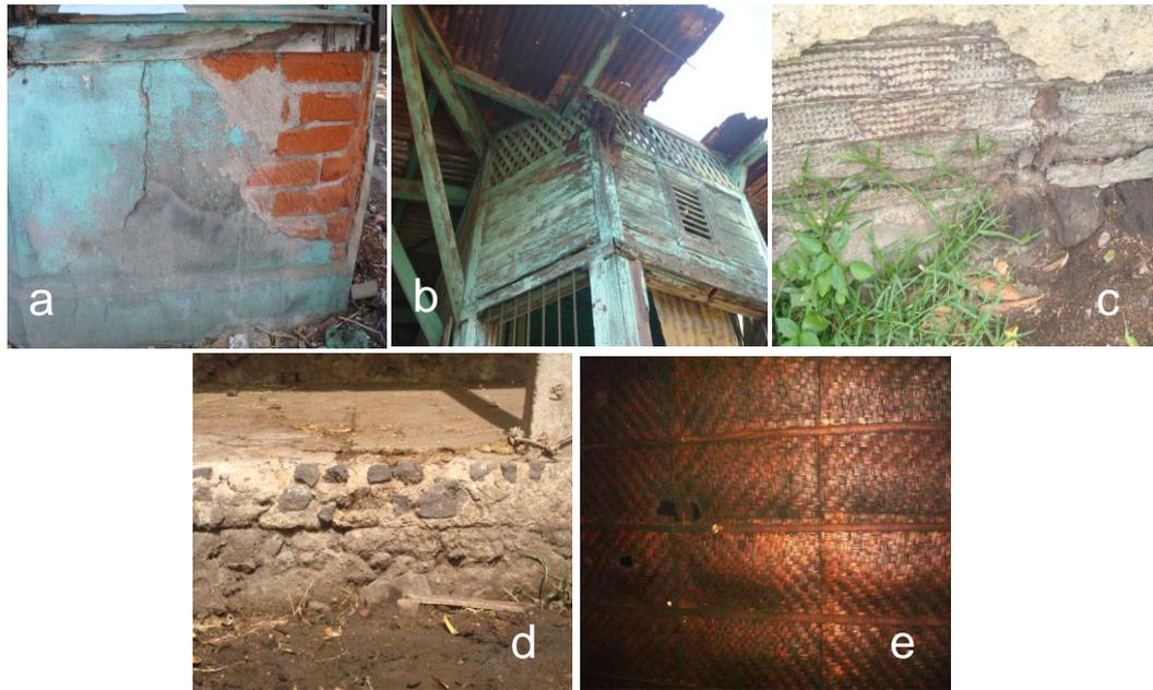
**Figura 39. Materias primas utilizadas para la construcción de inmuebles en Sitio del Niño: ladrillo (a), madera (b), deploye (c), roca volcánica (d) y tule (e)**
