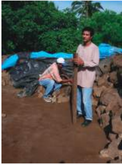
Fig. III-21 Compactación de la "mezcla" aplicada al Piso 1 (Fotografía: Shinya Kato, 19, septiembre, 2005)
