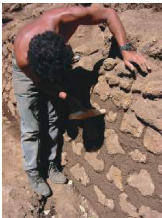
Fig. III-11 Compactación de la "mezcla" aplicada entre las piedras del muro (Fotografía: Shinya Kato, 4, febrero, 2005)
