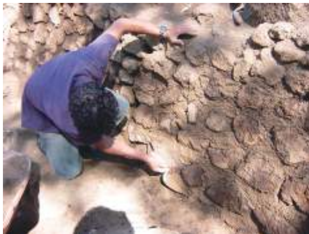
Fig. III-10 Aplicación de la "mezcla" entre las piedras del muro (Fotografía: Shinya Kato, 4, febrero, 2005)
