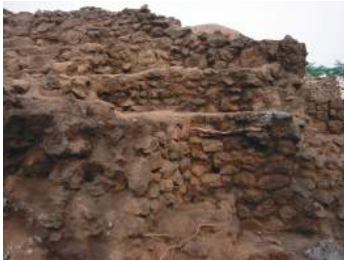
Fig. II-11 Raíces encontradas penetran en las Subestructuras de B1-2 Hacia el este (Fotografía: Shinya Kato, 3, marzo, 2005)
