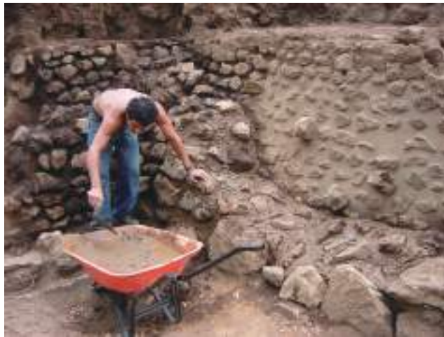
Fig. III-9 Aplicación de la "mezcla" entre las piedras (Fotografía: Shinya Kato, 29, marzo, 2005)
