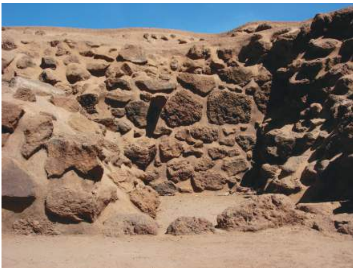
Fig. 70 Muro de la Fase I encontrado en el sector sur de la estructura B1-2 Hacia el norte (Fotografía: Shinya Kato, 24, noviembre, 2005)
