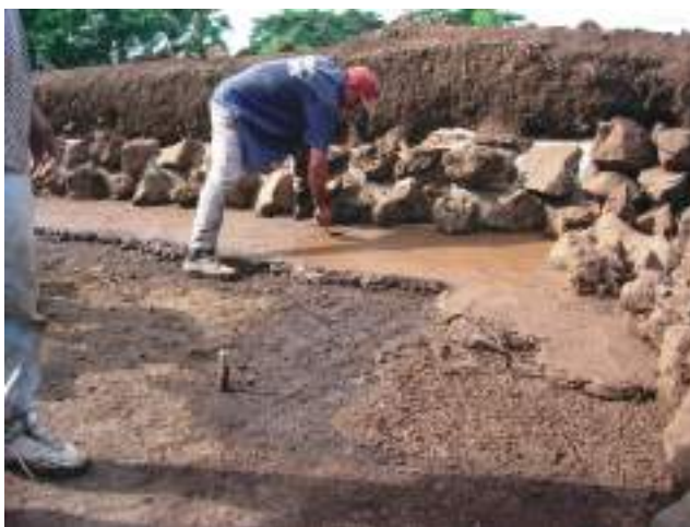
Fig. III-20 Aplicación de la "mezcla" sobre dos capas de tierra y tierra con balastro (Fotografía: Shinya Kato, 13, septiembre, 2005)
