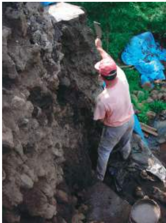
Fig. III-17 Aplicación del cemento a la estructura reconstruida por Boggs en el corte este del sector sur de la Estructura B1-2 (Fotografía: Shinya Kato, 29, septiembre, 2005)
