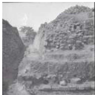
Fig. 13 Esquina noreste de la Estructura B1-2 Hacia el sur (Fotografiada en el 1945 por Boggs: Archivo de VIA Harvard, 45-16-55a)
