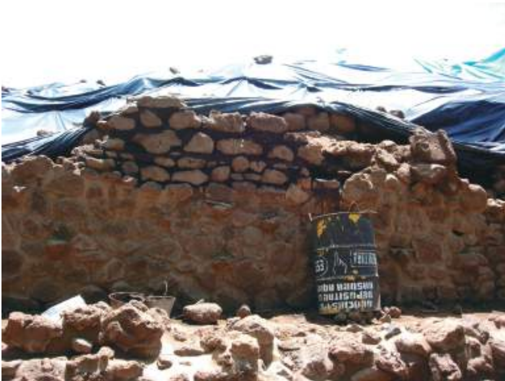
Fig. III-14 Parte restaurada para evitar el colapso: piedras recolocadas en base del resultado del levantamiento arquitectónico (Fotografía: Shinya Kato, 31, mayo, 2005)
