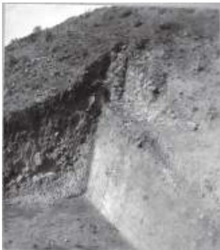
Fig. 20 Talud repellado en el lado oeste de la Estructura B1-2 Hacia el norte (Fotografiada en el 1948 por Boggs: Archivo de VIA Harvard, 48-16-39)
