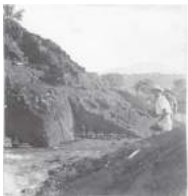
Fig. 23 Excavación del lado oeste de la Estructura B1-2 Hacia el sur (Fotografiada en el 1949 por Boggs: Archivo de MUNA, 49-2-2)
