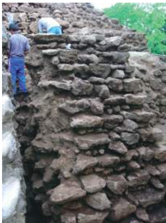
Fig. 102 Escalinata 2 y su sistema constructivo Hacia el sureste (Fotografía: Shinya Kato, 3, noviembre, 2005)
