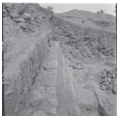
Fig. 11 Lajas alineadas sobre el talud en el lado norte de la Estructura B1-2 Hacia el oeste (Fotografiada en el 1945 por Boggs: Archivo de VIA Harvard, 45-16-53)
