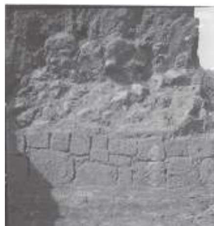
Fig. 18 Muro encontrado de mampostería en el lado sur de la Estructura B1-2 Hacia el norte (Fotografiada en el 1945 por Boggs: Archivo de VIA Harvard, 45-16-60)
