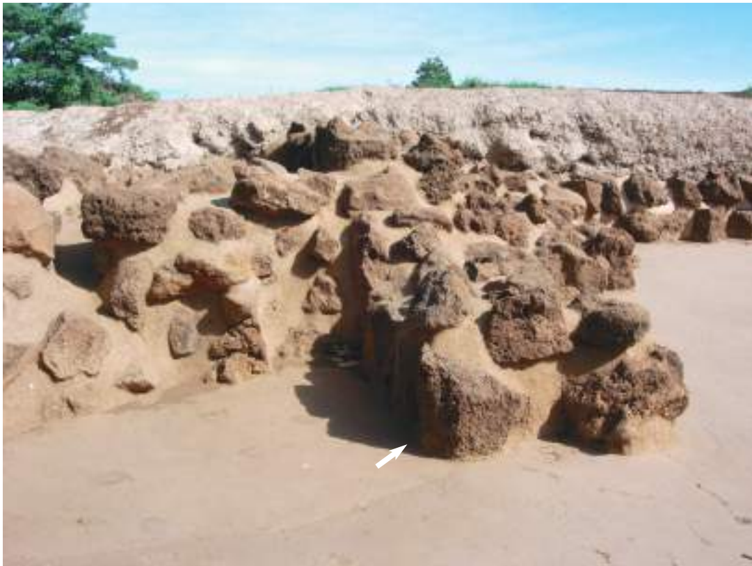
Fig. 87 Muro de la Fase IIIC construido sobre el Piso 1 Hacia el norte (Fotografía: Shinya Kato, 13, diciembre, 2005)
