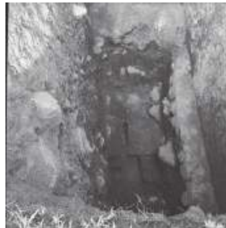
Fig. 7 Sistema constructivo con adobe en la Terraza Básica de la Estructura B1-2 Hacia el este (Fotografiada en el 1942 por Boggs: Archivo de VIA Harvard, 42-16-273)
