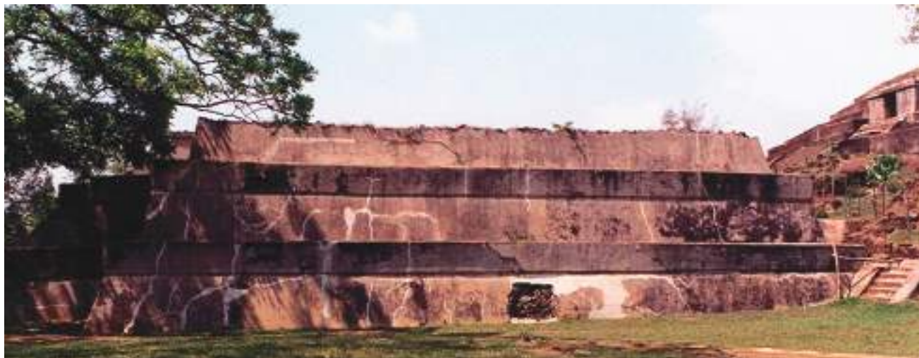
Fig. II-3 Antes del derrumbe en el sector sur de la Estructura B1-2
