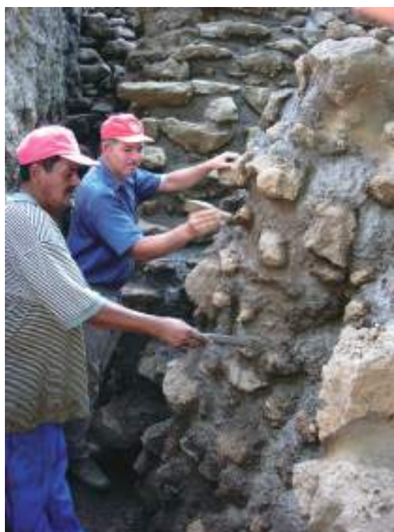
Fig. III-12 Compactación de la "mezcla" con compactadores hechos de bálamo (Fotografía: Shinya Kato, 9, noviembre, 2005)
