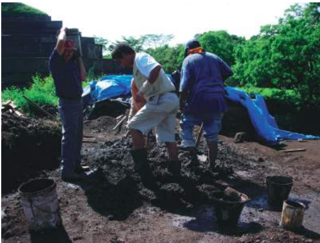
Fig. III-5 Preparación de la "mezcla", usando azadón y botas (Fotografía: Shinya Kato, 7, septiembre, 2005)
