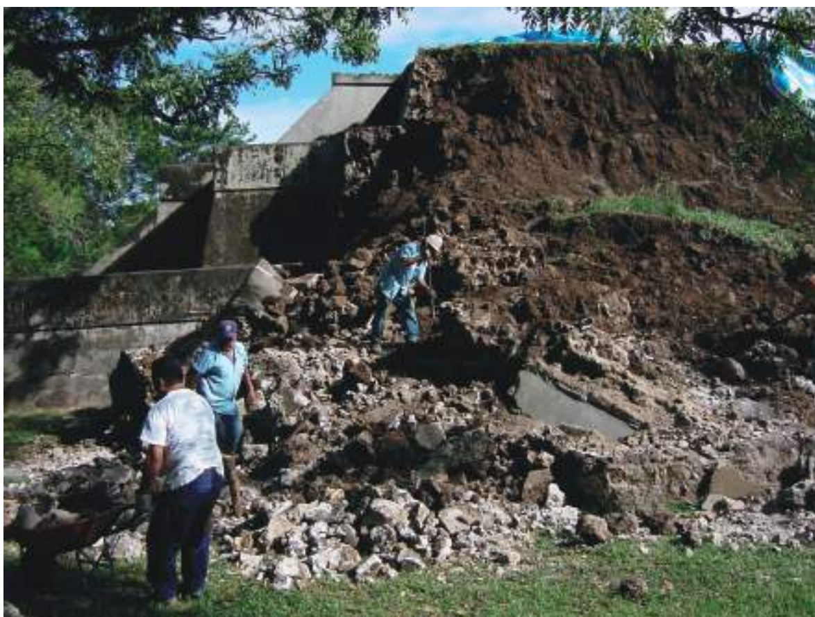
Fig. 37 Remoción de tierra, piedras y ripios de cemento colapsados en el 14 de octubre del 2004 Sector sur de de la Estructura B1-2 Hacia el sureste (Fotografía: Shinya Kato, el 14 de octubre, 2004)
