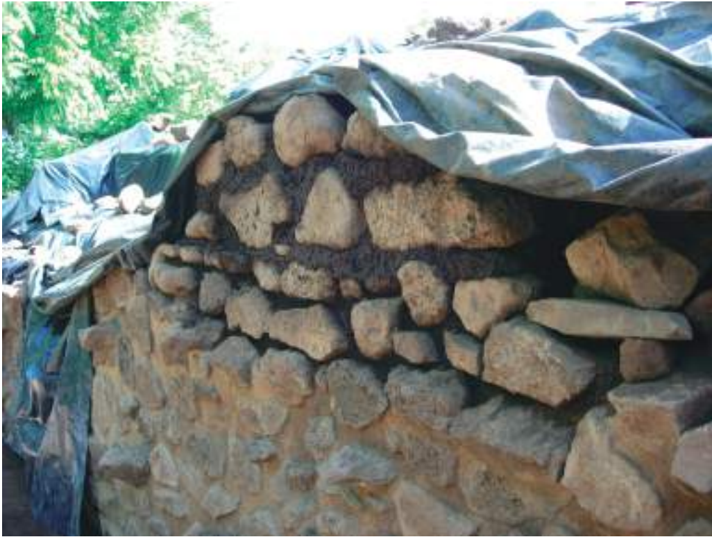
Fig. III-13 Restauración de la parte inclinada por la presión del relleno en el muro de la Fase IIIB (Fotografía: Shinya Kato, 31, mayo, 2005)
