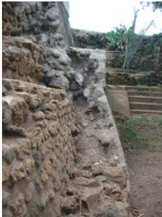
Fig. 114 Estructura de la Fase V cubierta con cemento Hacia el este (Fotografía: Shinya Kato, 29, noviembre, 2005)
