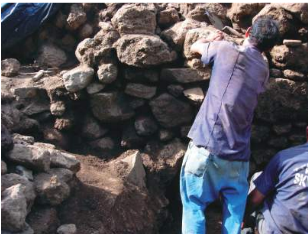
Fig. III-6 Remoción del relleno prehispánico entre las piedras del muro (Fotografía: Shinya Kato, 29, julio, 2005)
