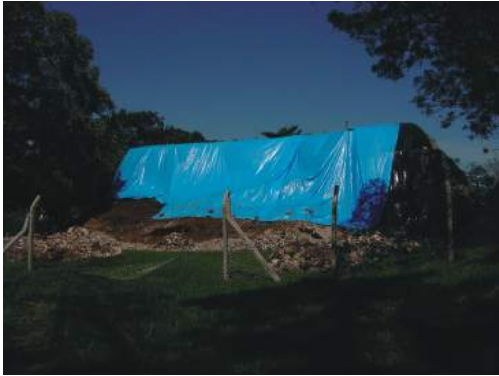
Fig. II-5 Estructura B1-2 rodeada con una malla protectora y tapada con plástico Hacia el norte (Fotografía: Shinya Kato, 17, diciembre, 2004)
