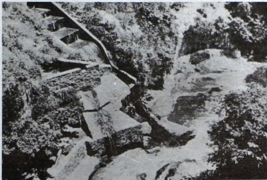
EROSION. El mal diseño de las tuberías de aguas negras y lluvias ha erosionado los tramos superiores del río Urbina.
