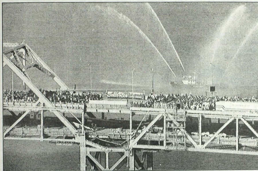
REAPERTURA. Mientras el bote bombero "Fénix", lanza agua de sus monitores, oficiales cortan la cinta simbólica de la reapertura del puente sobre la Bahía San Francisco-Oakland. El puente fue dañado por el reciente terremoto. Miles caminaron sobre el puente durante la celebración.
