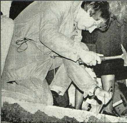
Iniciase simbólica demolición
