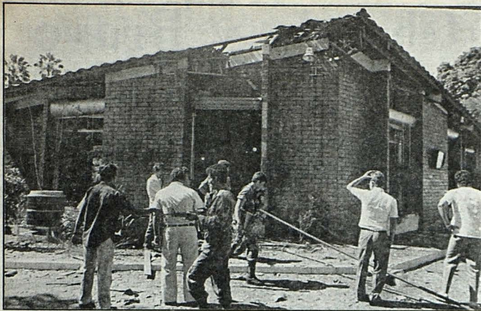
—Foto de LA PRENSA, por Larín. NEGOCIO DESTRUIDO. El restaurante "Pollo Campero" ubicado esquina opuesta al Estado Mayor, fue uno de los negocios dañados por las bombas lanzadas ayer al Estado Mayor Conjunto de la Fuerza Armada, resultando dos dependientes heridos.
