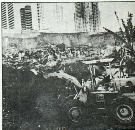
Remoción de escombros
