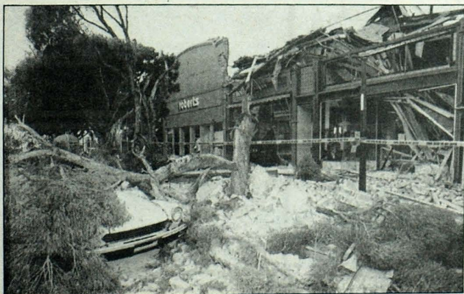
Estragos parciales de un terremoto
