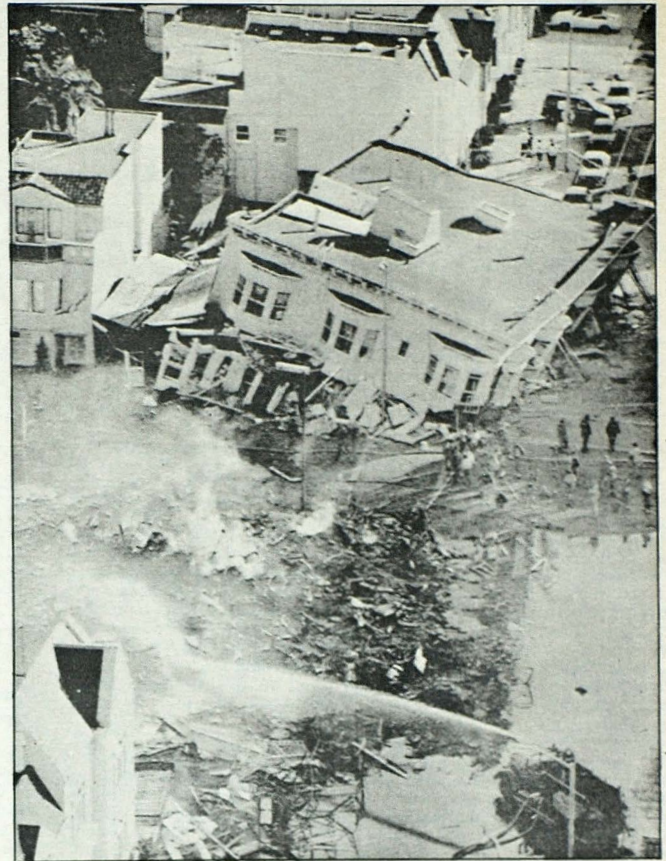
DAÑOS EN EL DISTRITO MARINA
