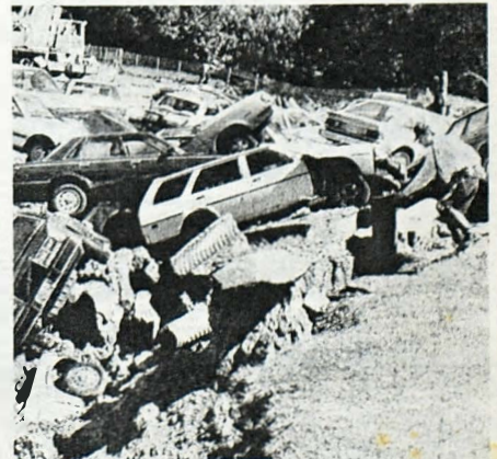
HUNDIMIENTO. Glen Echo, Maryland, EE.UU., Mayo 6 (AP-cablefoto). Un oficial de policía inspecciona algunos de los 25 automóviles dañados ayer en un parqueo, después que una alcantarilla se hundió durante un fuerte aguacero.
