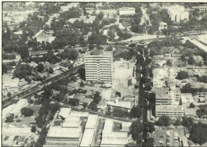
SIGUE LA REPARACION. Vista aérea del Hospital Bloom, cuyos trabajos de reparación continúan. El edificio fue dañado por el terremoto de 1986 y actualmente funciona en un local provisional.
