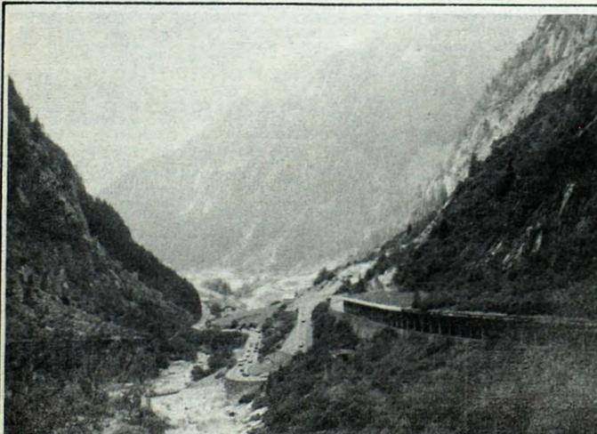
**CARRETERAS CON TECHO.** Zurich, Suiza. Vista parcial de una de las carreteras con techo, bajando de Los Alpes, para evitar los efectos de los aludes.
