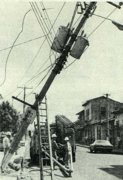
**REPARACIONES.** Trabajadores de la Compañía de Alumbrado Eléctrico de San Salvador realizan reparaciones en un poste sostenedor de cables de energía eléctrica, derribado por un vehículo.
