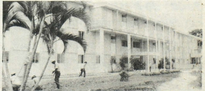
NUEVO HOSPITAL. El 26 de este mes será inaugurado el nuevo hospital de Especialidades del Rosales, el cual ha sido construido con donativo del Gobierno de Francia y préstamos de AID. El costo de la construcción asciende a 25 millones de colones, dijo el Dr. Carlos Humberto Castelar.
