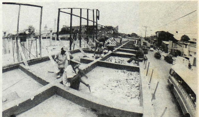
RECONSTRUYEN SAN MIGUELITO. Dentro de un año dos meses estarán concluidos los trabajos de remodelación del mercado San Miguelito, en est. capital. Los trabajos se llevan a cabo con financiamiento del AID, MIRA y fondos propios de la Alcaldía.
