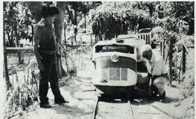
MEDIDAS DE SEGURIDAD. Reparar y hacer más alta la malla ciclón que protege el tren en el Parque Infantil y cambiar algunos "durmientes" para evitar una tragedia, recomienda don Alberto Heilebuyck. Izquierda, empleado y testigo del accidente en el que murió una estudiante el miércoles pasado.
