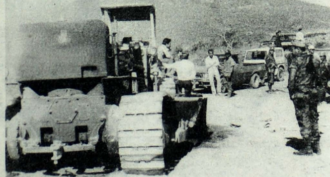
MAQUINARIA DINAMITADA. Terroristas del FMLN dinamitaron maquinaria de la ANDA en el cerro El Carmen, de Ayutuxtepeque, al norte de San Salvador. No se reportaron daños personales.
