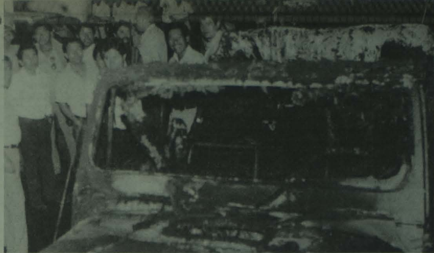
DAÑAN 7 VEHICULOS. Cinco sujetos armados de metralletas incurrieron a la División de Malariaología, del Ministerio de Salud, donde incendiaron 7 vehículos de ese ministerio. Es la tercera vez que los terroristas causan graves daños a los laboratorios de Salud.
